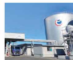
アスファルト基地
