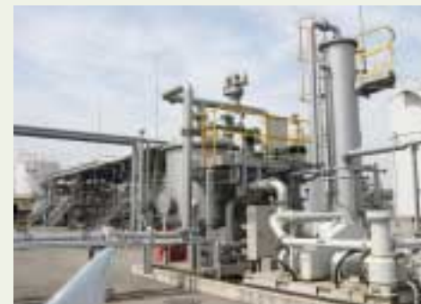
ベーパーを液化回収する装置
