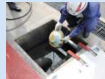
油水分離層の定期点検
